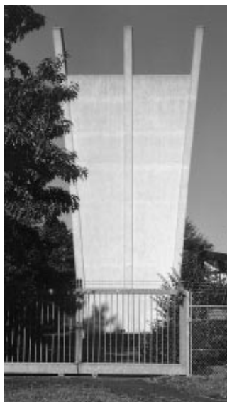
Verschlossen: Das Luftbrücken-Denkmal an der A 5. Bulletin-Foto: Metzger
